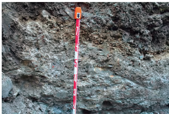
Fig. 29: Estructura de hormigón, probablemente medieval andalusí, localizada en el primer tramo de la calle, en el lado de los números pares (colegio). Su función no se ha podido determinar.
