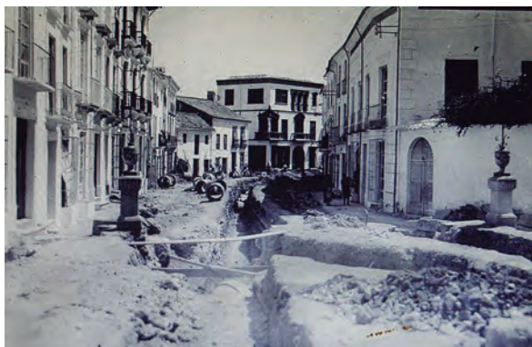
Fig. 3: Obras realizadas entre 1927 y 1929 en la calle Río y que supusieron la eliminación del canal histórico existente en este viario desde el siglo XVI. Se pueden observar los tubos de hormigón armado dispuestos para su colocación y que han sido retirados, a su vez, durante las obras de 2022-2023.
