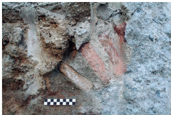
Fig. 23: Detalle de la foto anterior. Arranque de la bóveda de ladrillo.
