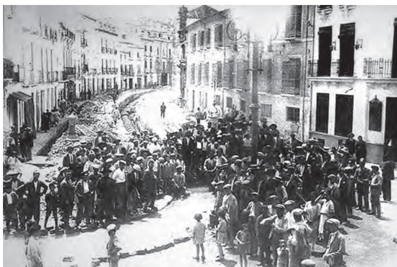
Fig. 12: Panorámica de las obras de encauzamiento del arroyo de la Fuente del Rey en los años 1927-1929 y que supusieron el desmantelamiento casi total del canal que se construyó en el siglo XVI, aéreo, convenientemente remozado con posterioridad, y que se había ya cubierto en el siglo XIX. Se puede observar en la calle la tubería central de hormigón armado (UE 8 del sondeo de 2000), recién colocada.
